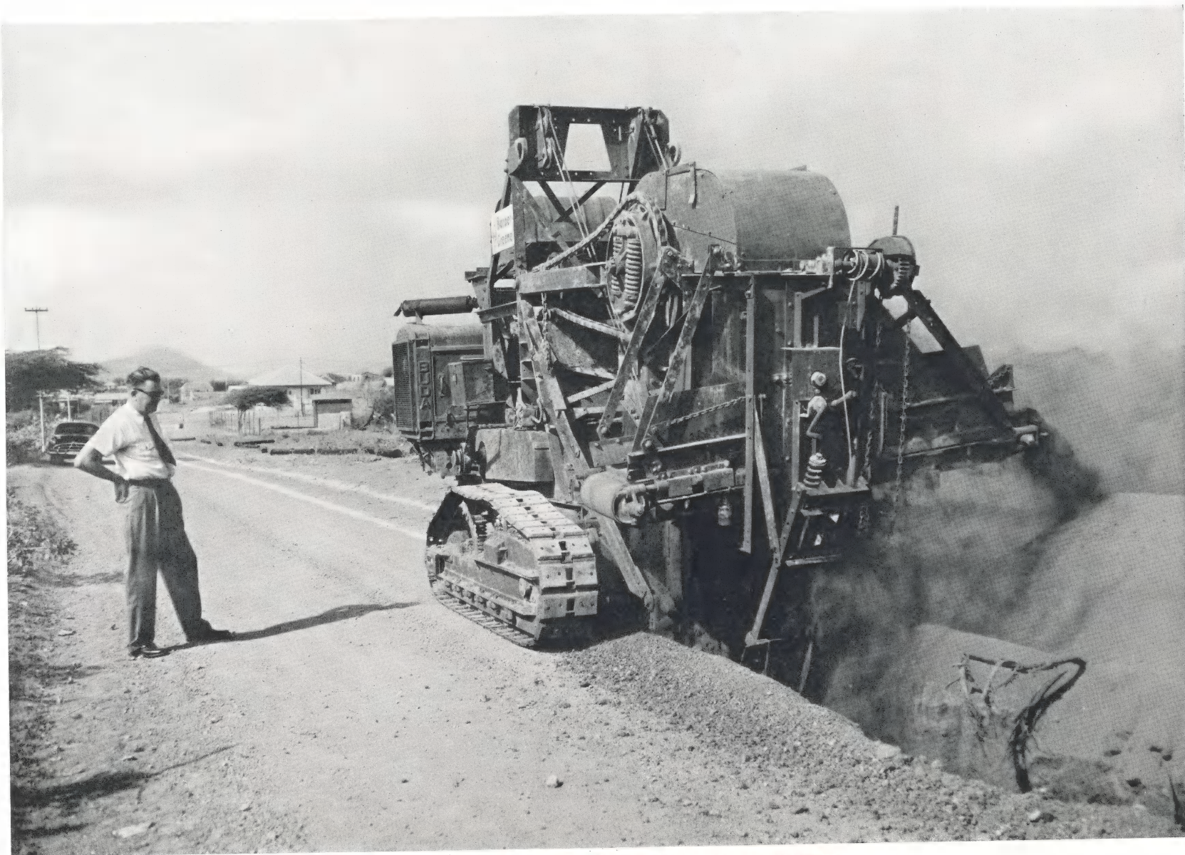
HET GRAVEN VAN SLEUVEN IN DE TEGENWOORDIGE TIJD COBAMENTU DI CANAL DEN TEMPU MODERNO GROOVE DIGGING NOWADAYS
